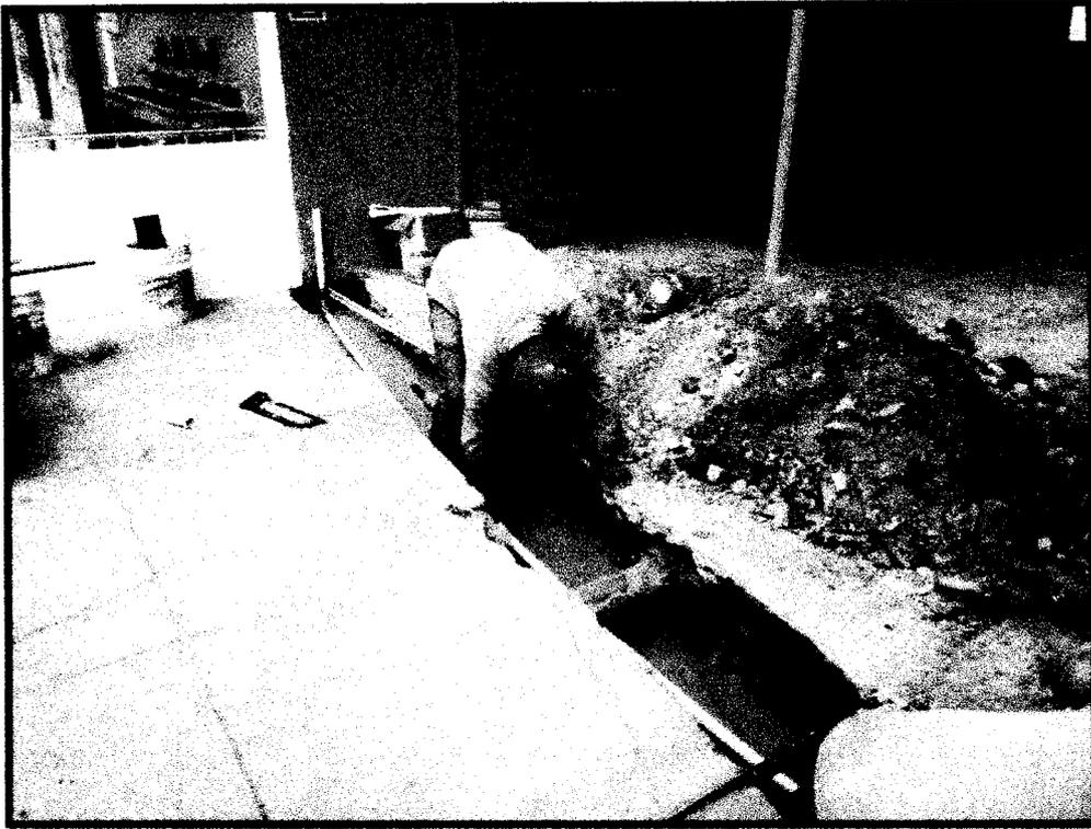
Se aprecias trabajos de instalaciones sanitarias – rotura de vereda para pasar los cables que suministrarán de energía las zonas 01, 02 y 03
